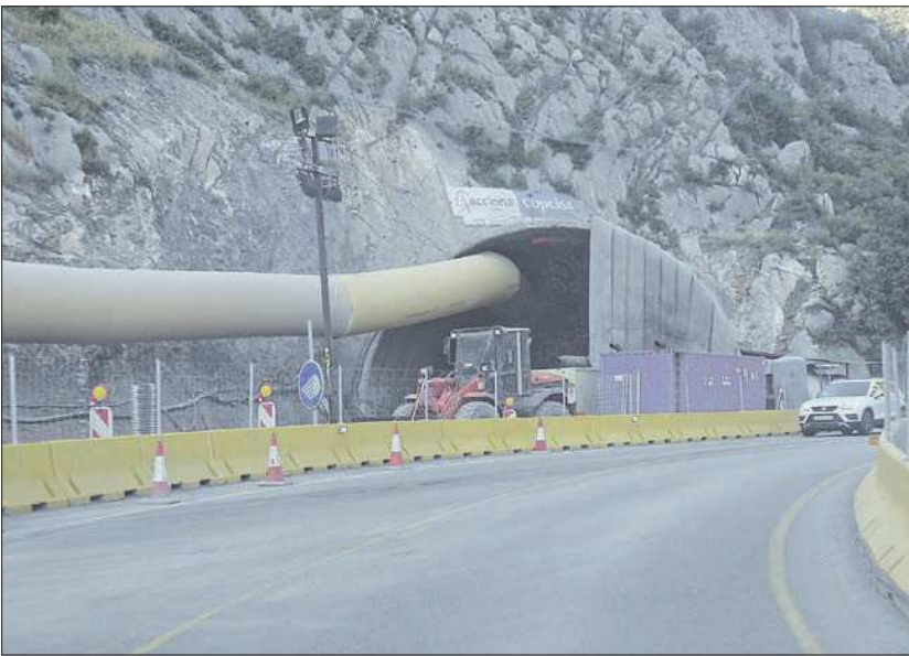
►► El túnel de Trespunts.
