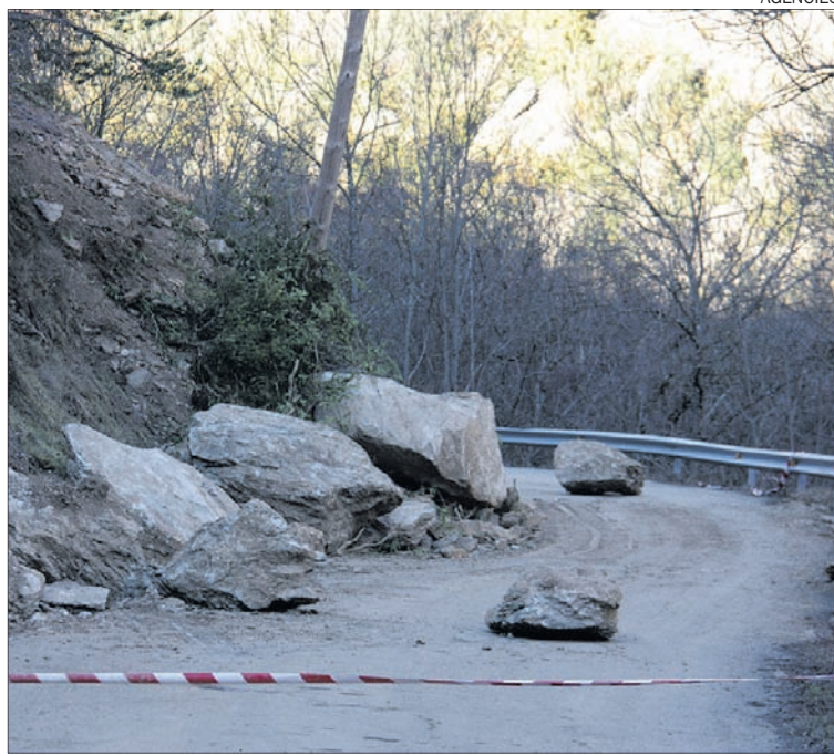
Roques que han caigut a la carretera local que va des de l'N-145 a diversos nuclis.
