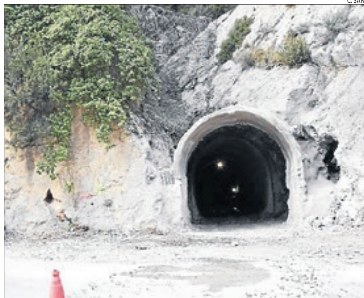
La primera galeria d'evacuació que s'ha perforat.
