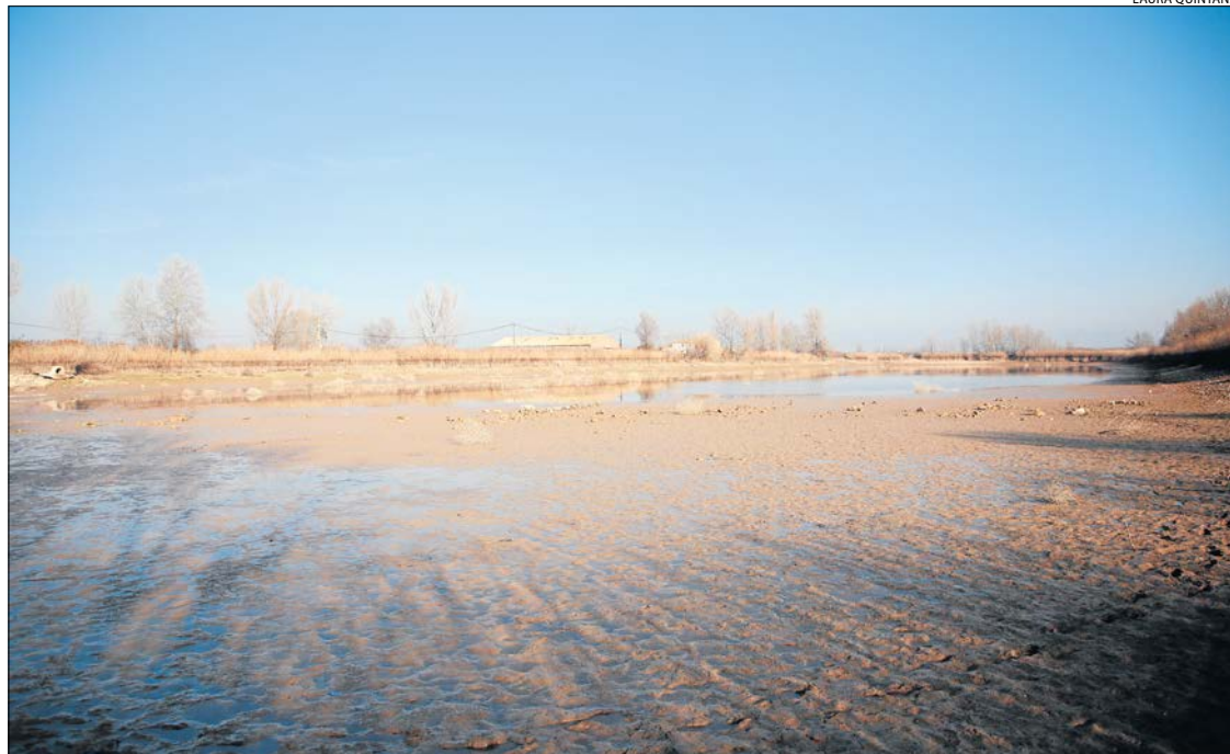
La bassa de Barretpicat del Canal d'Urgell entre Bellvís i Tèrmens, que s'ha buidat.
