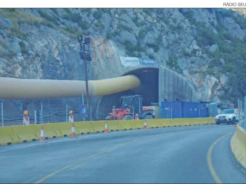
► Obres de construcció del túnel de Trespunts.
