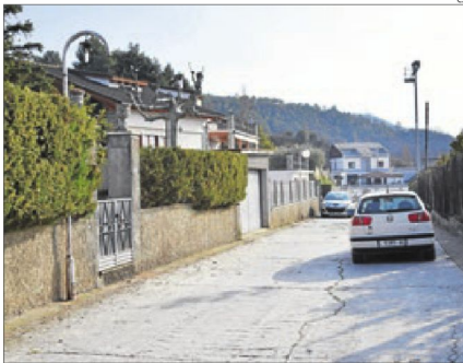
Un dels carrers que es beneficiaran de la millora de l'enllumenat.
