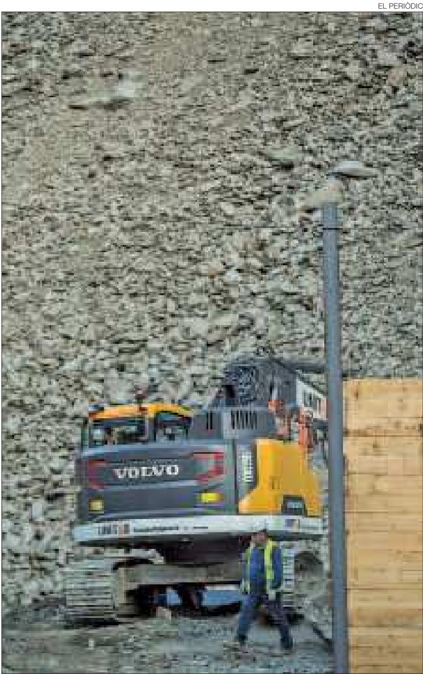
►► Obres de contenció de la zona de la Portalada, a l'estiu del 2019.
