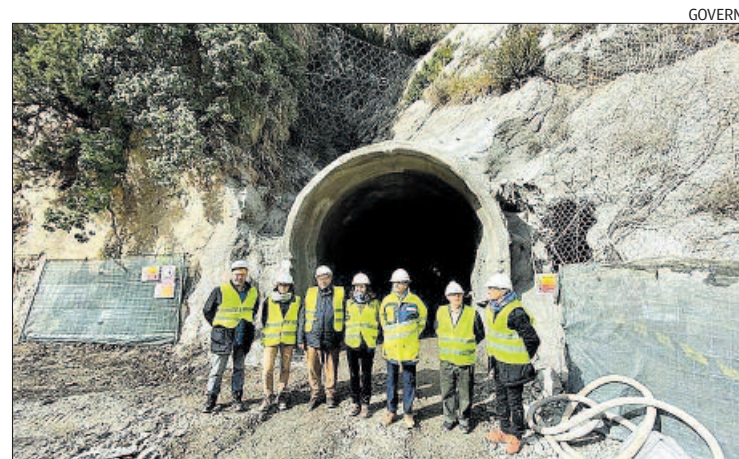
La visita d'obres amb el secretari d'Infraestructures, Isidre Gavín
