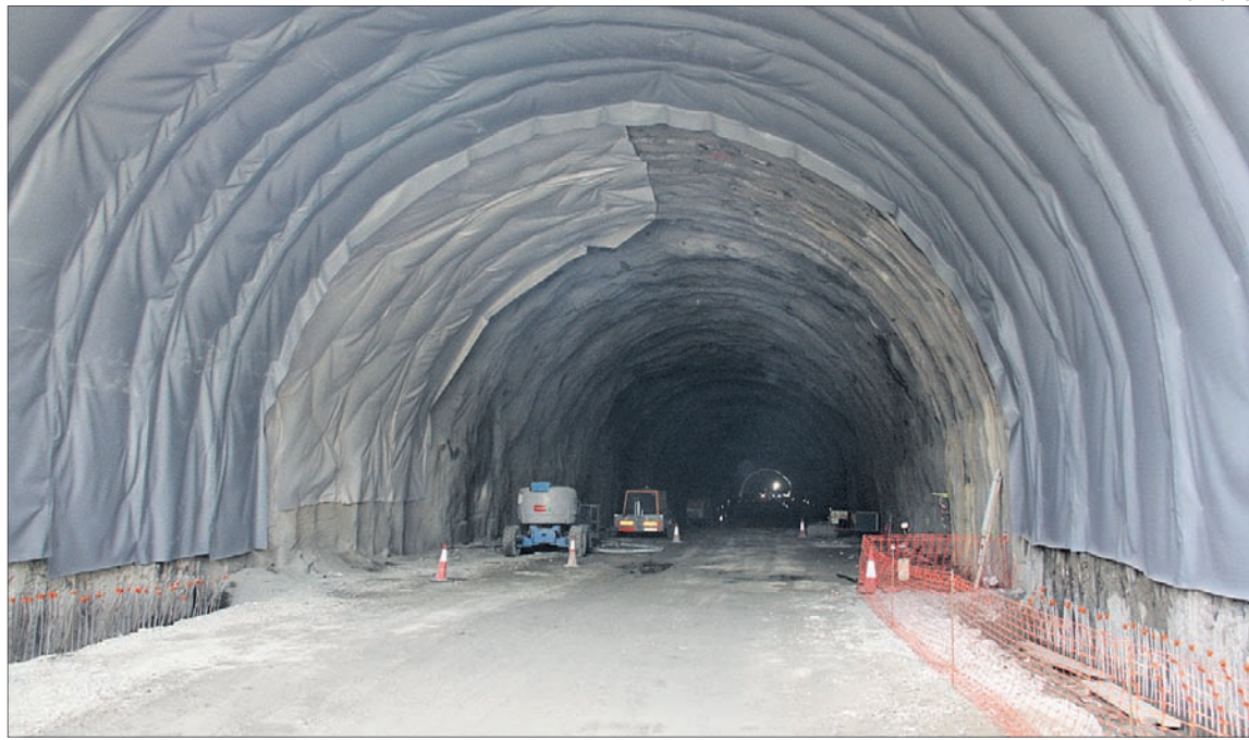
Interior de la galeria principal del túnel de Trespunts, a la C-14 entre Organyà i Montan de Tost.
