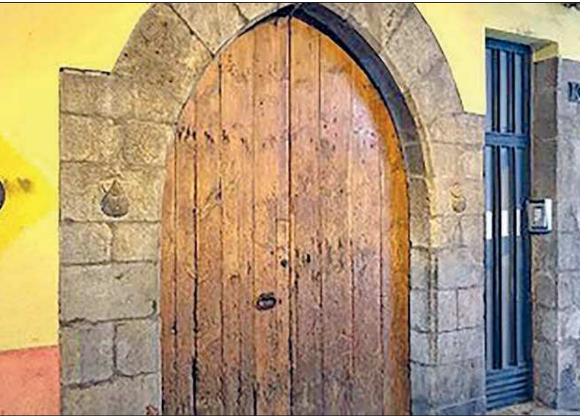
► Cal Roger, al carrer dels Canonges, futura porta d'entrada al museu.
