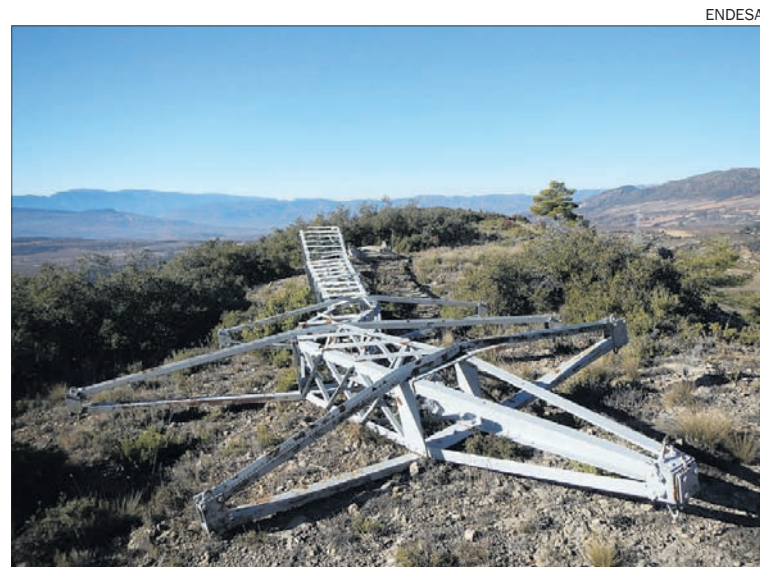
Una torre d'Endesa durant el procés de desmuntatge.
