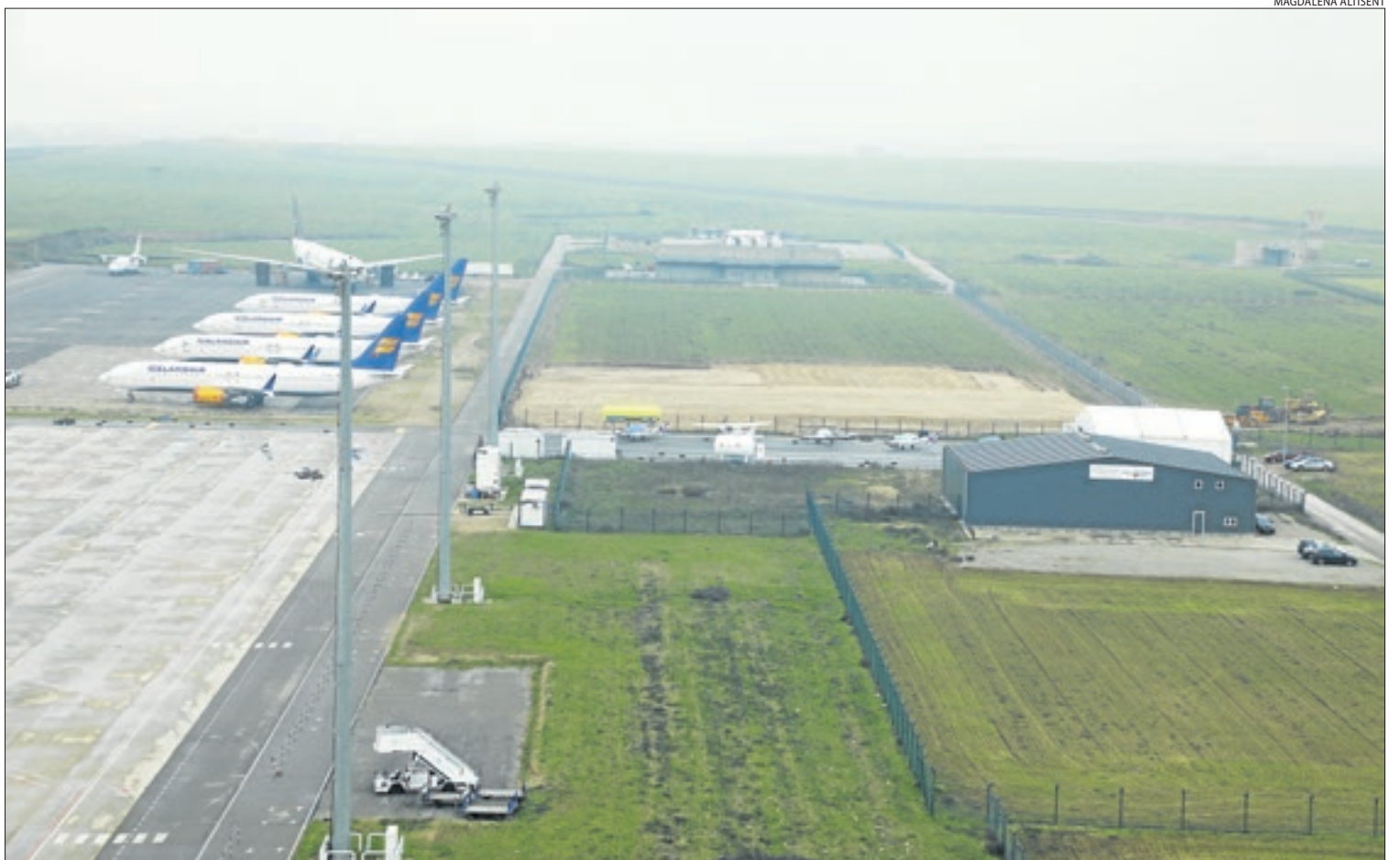
Moviments de terres aquesta setmana a la zona on es construiran hangars per a empreses al recinte aeroportuari d'Alguaire.
