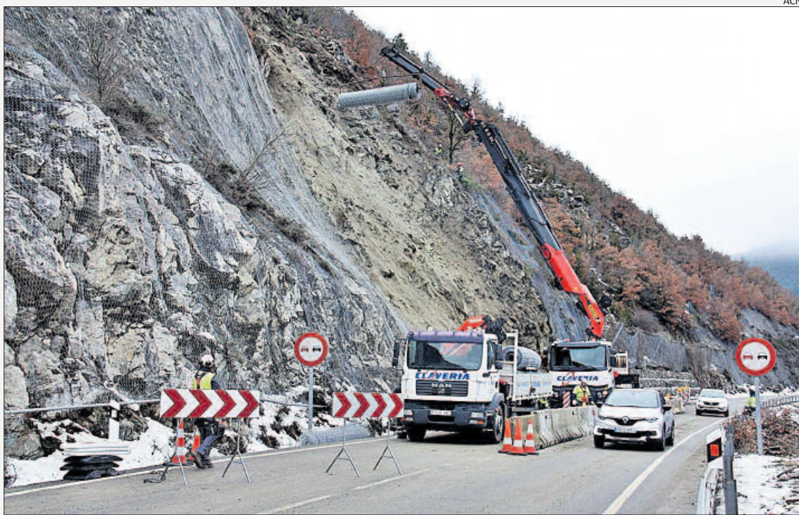
Ahir es va instal·lar una malla al punt del desprendiment
