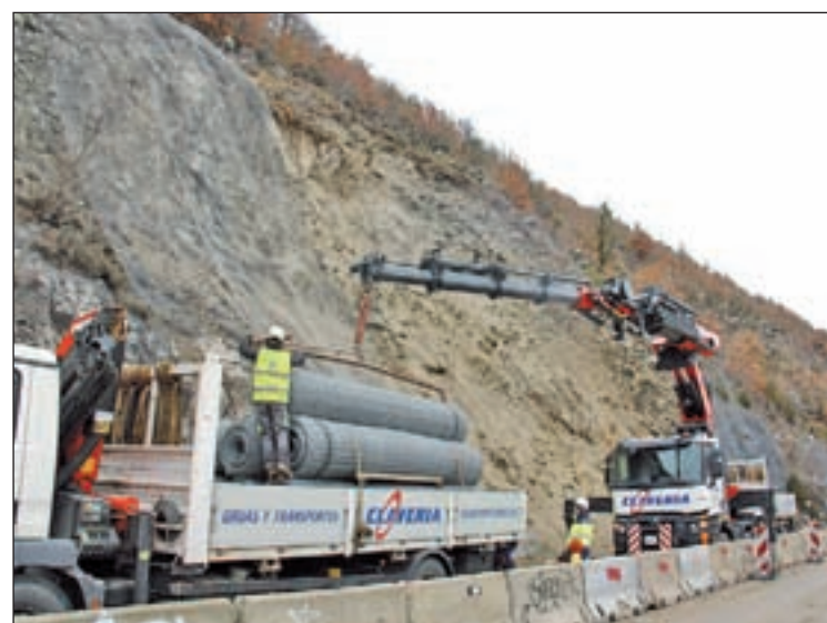
FOTO: ACN/ Operaris treballant amb una grua a la carretera N-260
