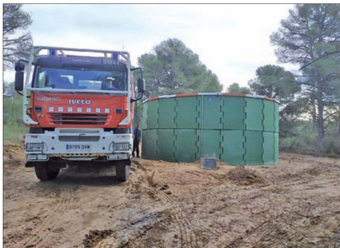
FOTO: L.M./ Imatge del dipòsit que s'ha construït a la finca Mas de Noguers de Maials
