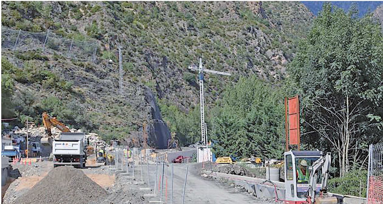
► Operaris treballant en el futur vial de Sant Julià de Lòria.
