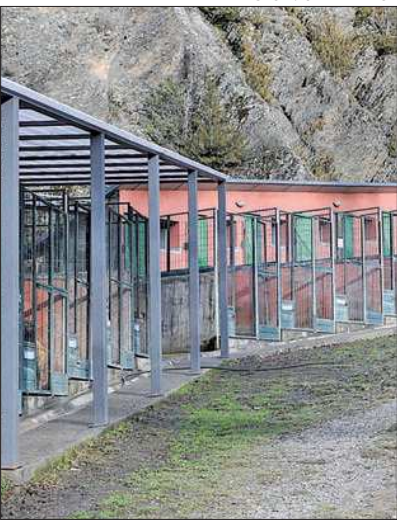
► Les instal·lacions de la gossera.
