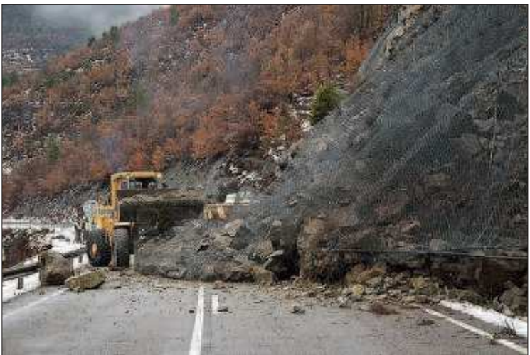
Zona afectada per l'esllavissada a l'N-260.
