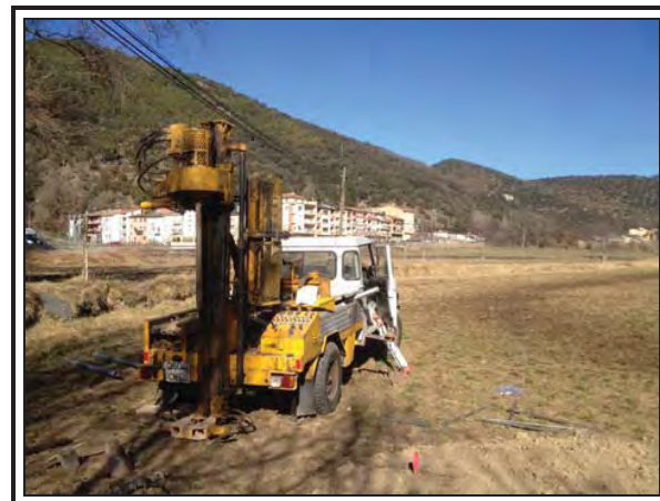
Foto 1. Treballs de realització del sondeig 1.
