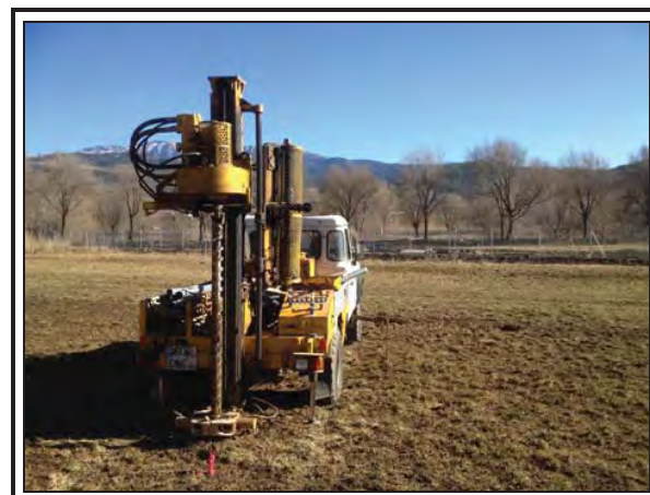
Foto 2. Treballs de realització del sondeig 2.
