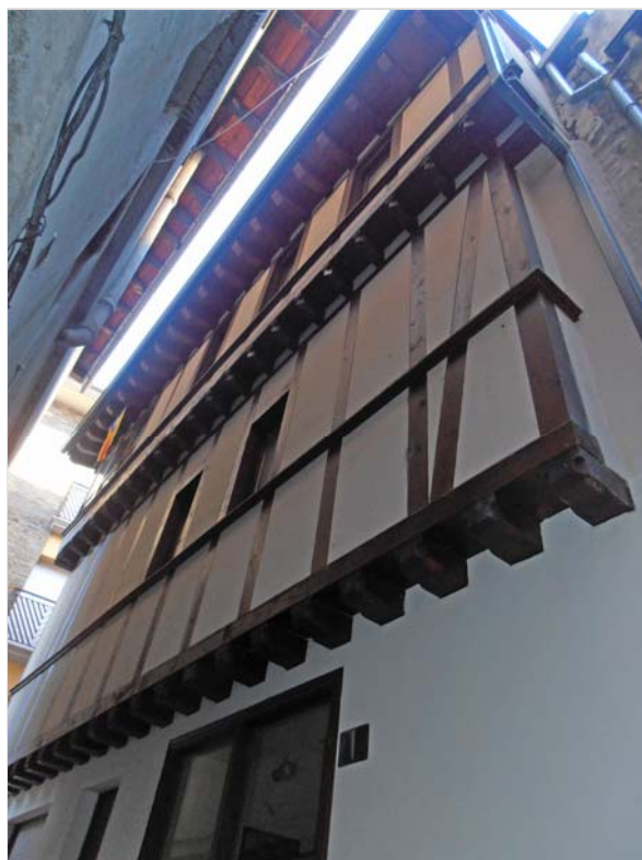
Detall de l'esgraiat en façana (2015)
