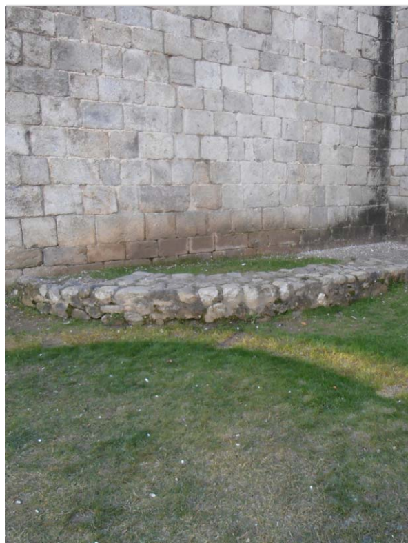
Detall de la zona d'excavació (2014)
