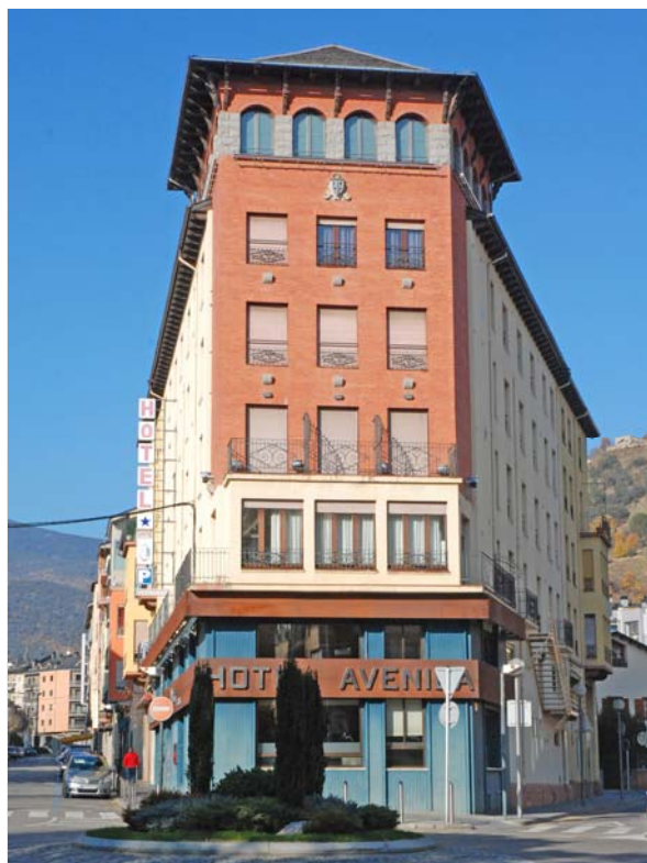
Torre que culmina el creuament entre Av. Pau Claris i el C. Garriga i Massó (2015)
