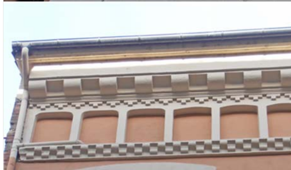
Detalls de les balconeres amb baranes de ferro treballat (2015) Detall dels arcs cecs i fris en el coronament de la façana (2015)
