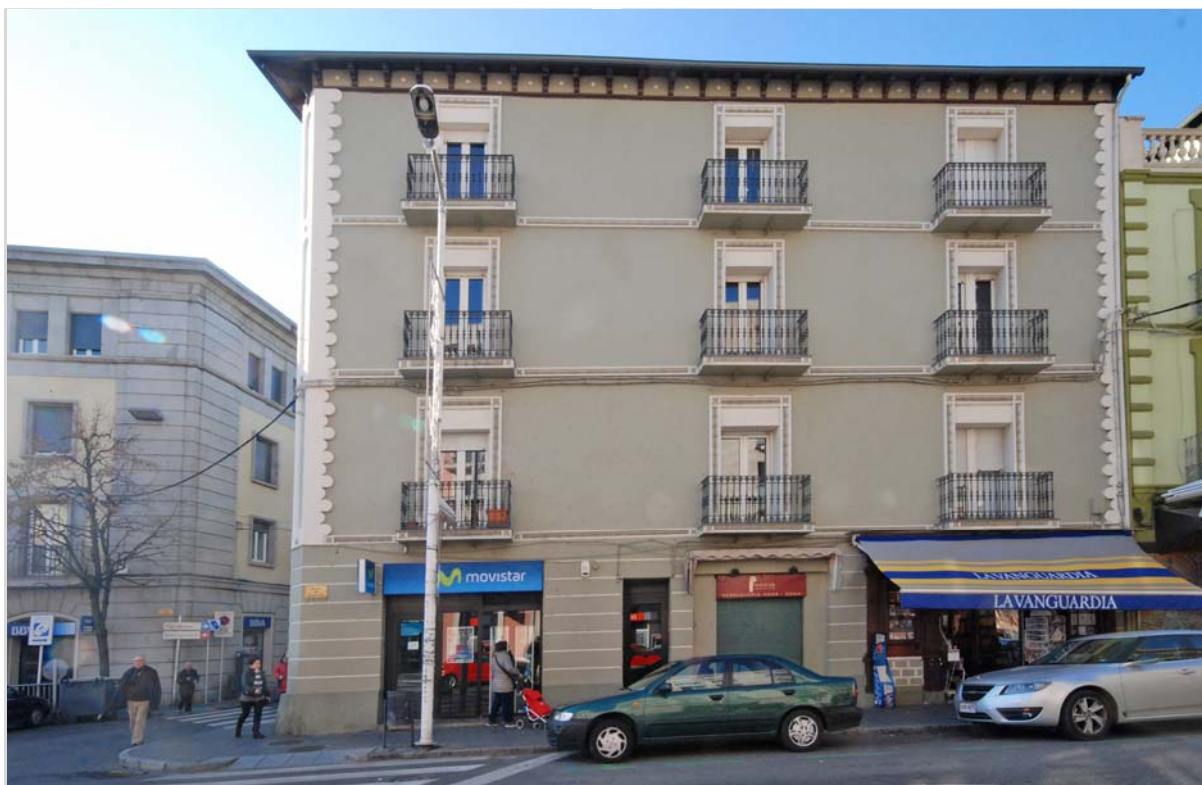
Façana del Carrer Sant Ot (2015)
