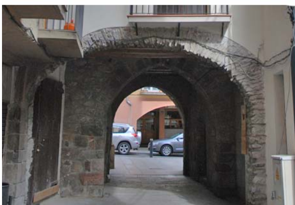
Balconera balustrada. Arc Rebaixat (2014)
