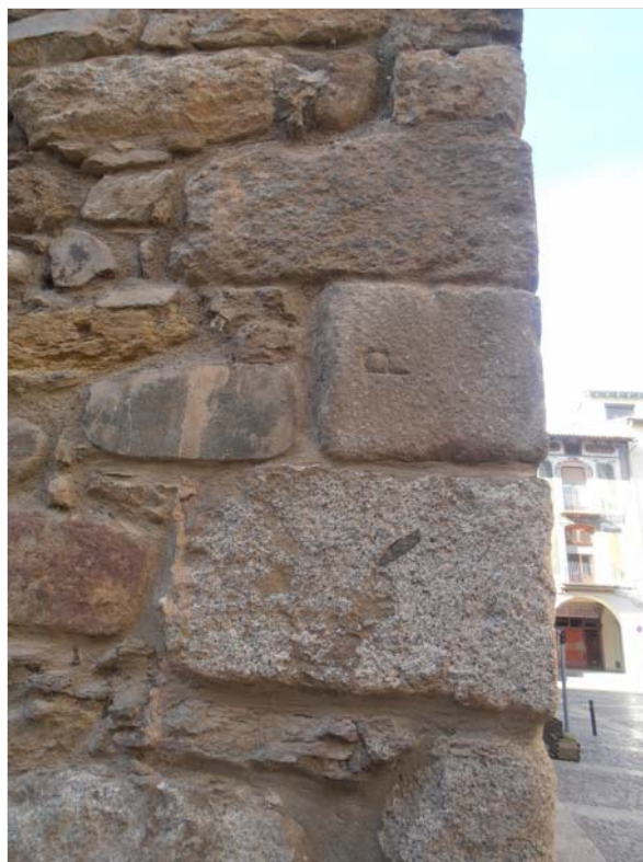
Carreus treballats en cantonada (2015)
