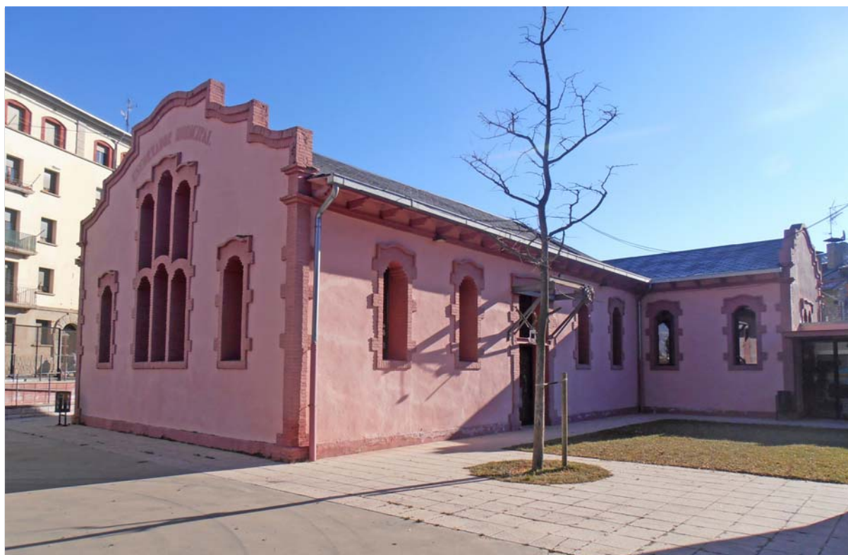
Edifici en forma de T, amb la façana principal orientada a nord (2015)
