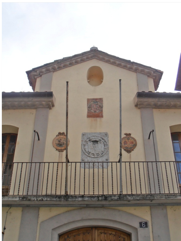
Escuts situats en la façana principal (2014)
