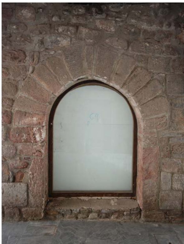
Porta adovellada interior, situada a llevant (2014)
