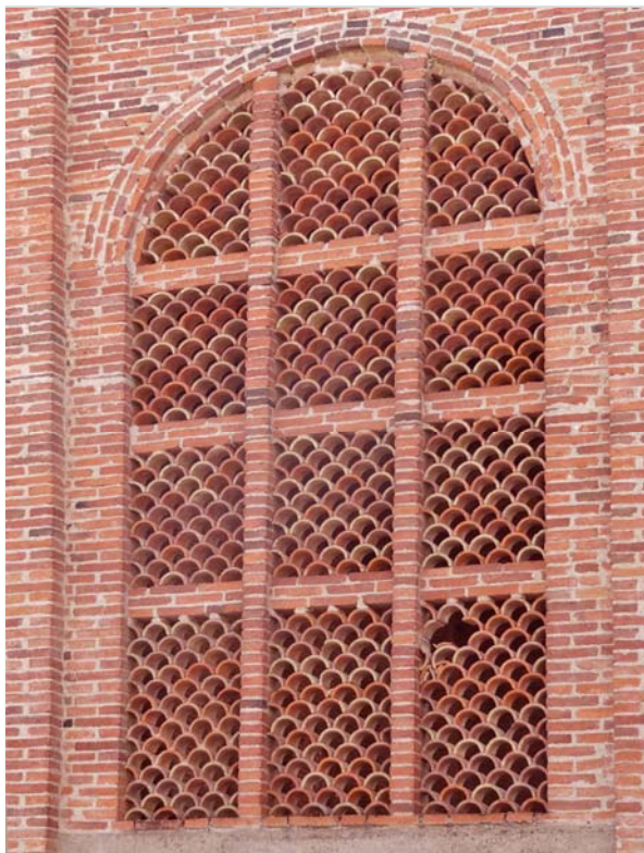
Detall d'obertures amb teules superposades (2015)
