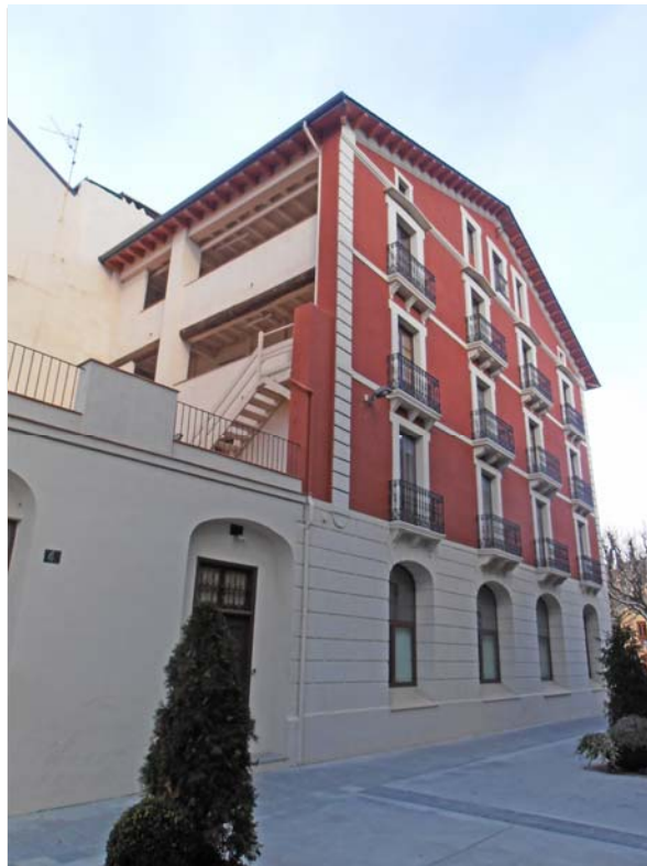
Pstge. de l'Alzina. La façana de ponent és la menys treballada (2015)
