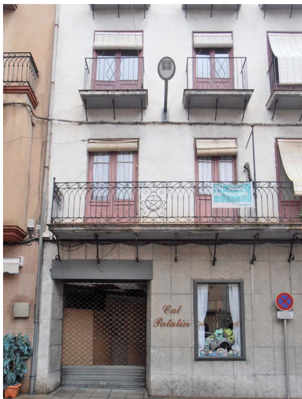
Detall balconada de la primera planta recolzada sobre suports de ferro (2014)
