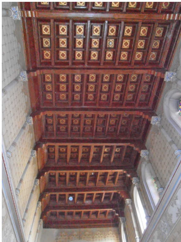
Detall coberta de fusta (20014)
