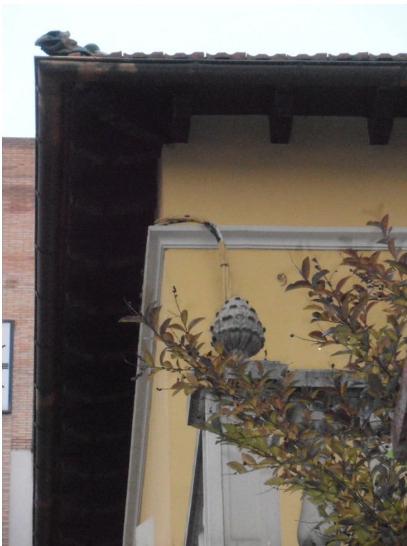
Caps de griu com a remats en la recollida d'aigua de pluja
