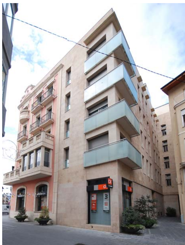
Cantonada Carrer de St. Josep de Calassanç (2015)
