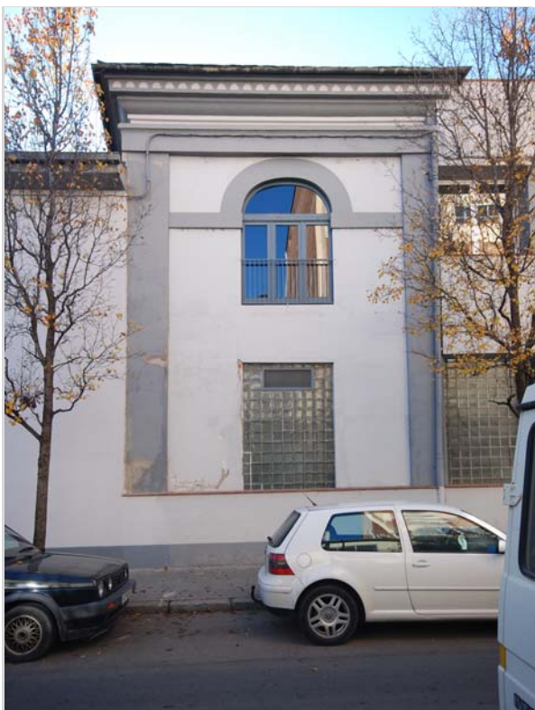
Última finestra d'arc de mig punt que queda de l'edifici Original (2015)
