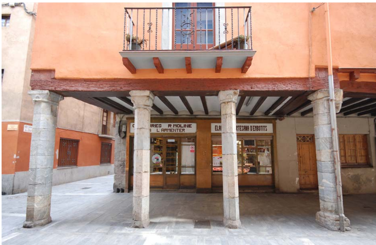
Pilars amb capitells esculpits de la façana del Carrer Canonges (2014)
