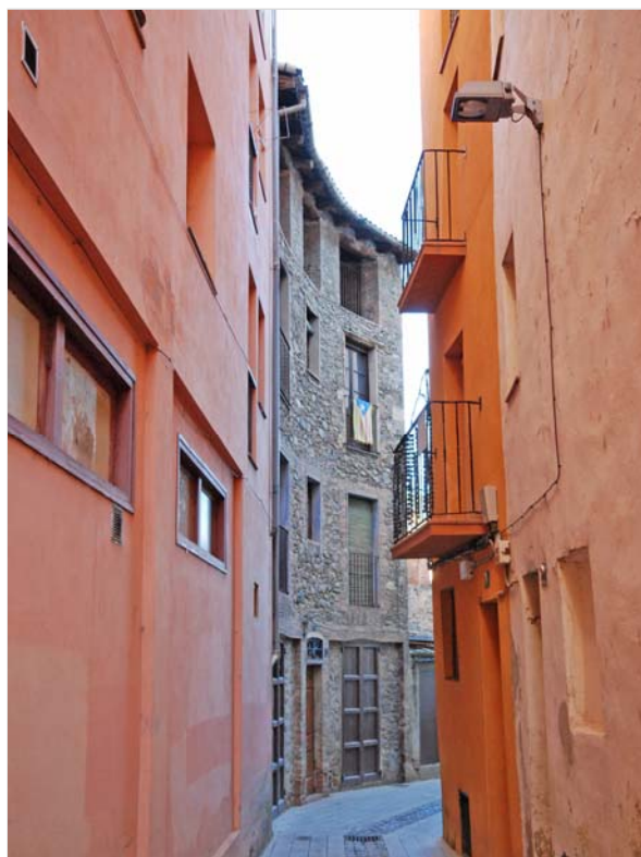
Façana oberta al carrer de Les Eres
