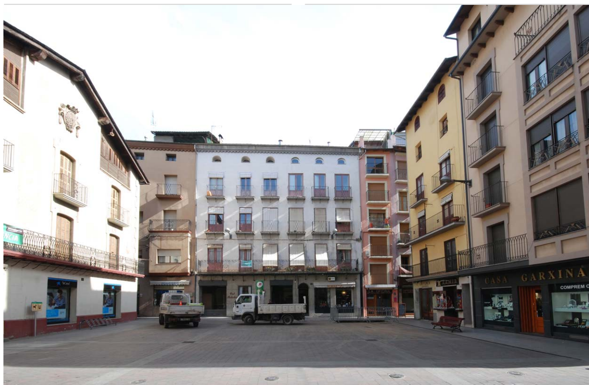
Conjunt de la Plaça Patalín, amb la façana de Cal Patalín al front, i a l'esquerra Cal Mossèn Andreu BCIL CH04 (2014)
