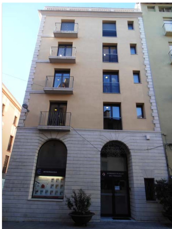
Façana oberta al Carrer de St. Josep de Calassanç (2014)
