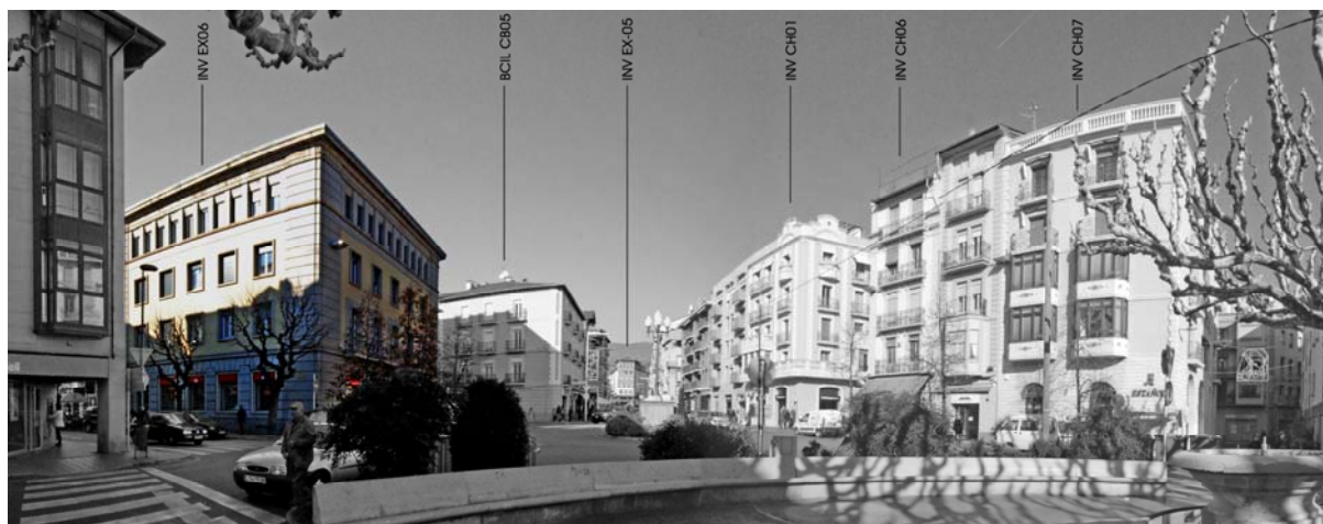
Plaça Catalunya, amb l'edifici Banc Espanyol de Crèdit a l'esquerra (2015).
