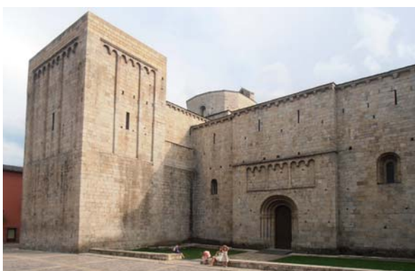
Façana nord. Torre inacabada façana nord. (2014)
