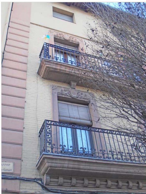
Balconeres amb baranes de ferro forjat (2015)
