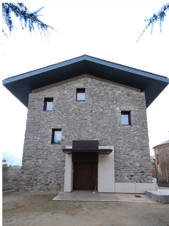
Façana oberta al Parc del Cadí
