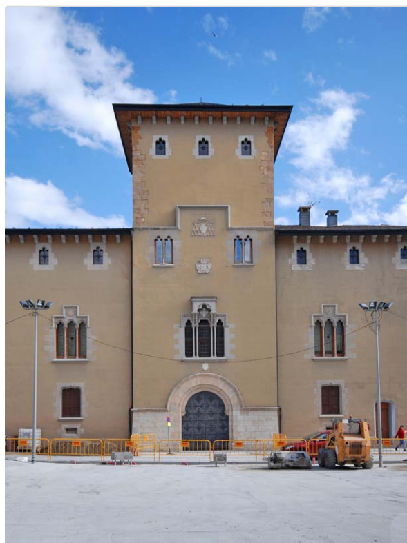
Torre cantonera de la façana de ponent. (2015)
