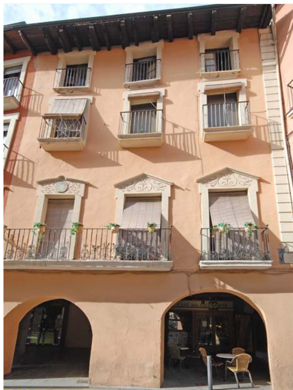
Cal Tarragona 1 vist des del Carrer Major. (2015)
