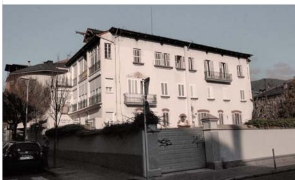
Façana lateral orientada a sud (2015)
