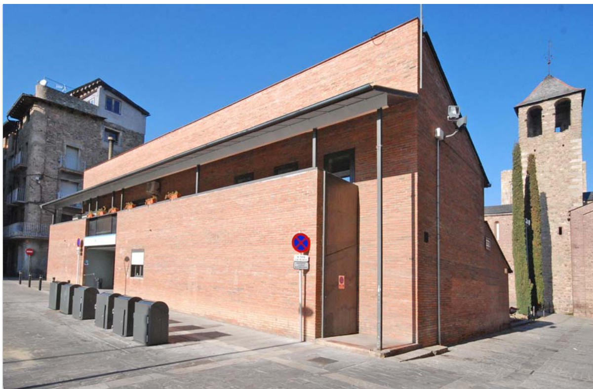
Façana oberta a la Plaça Pati Palau
