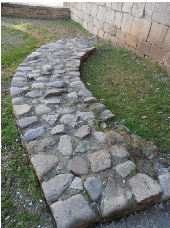
Mur de carreuó de perfil curvilini (2014)
