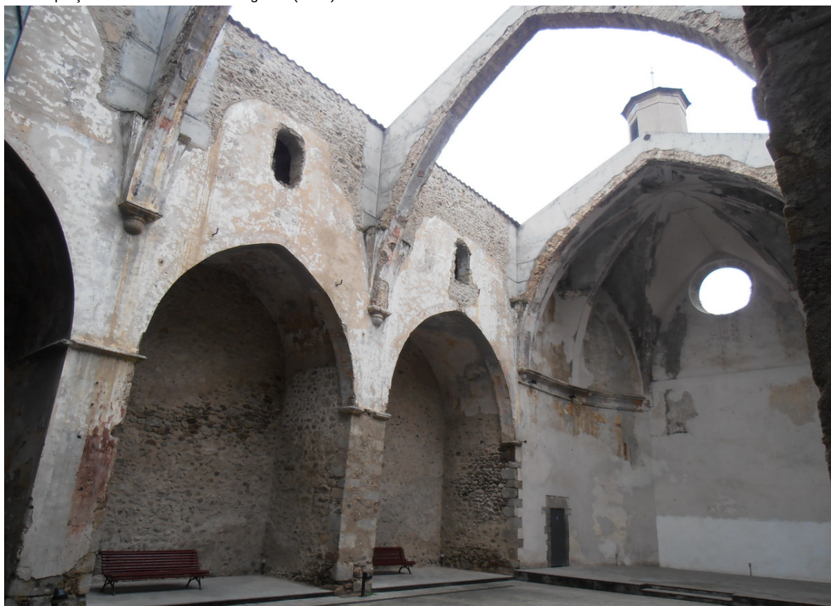
Nau central descoberta encapsada per una absis cobert ver una volta de creueria nervada.
