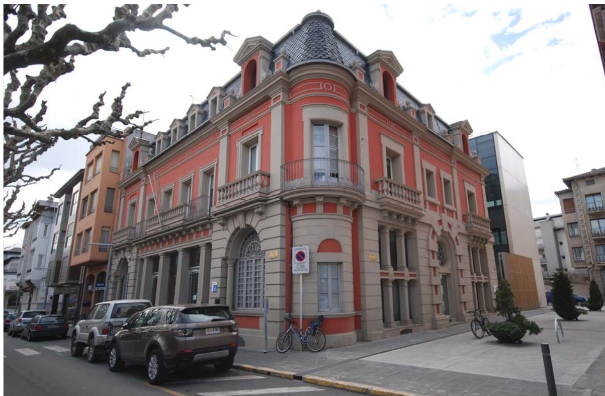
Façanes de llevant i nord, són les més treballades a nivell ornamental (2015)
