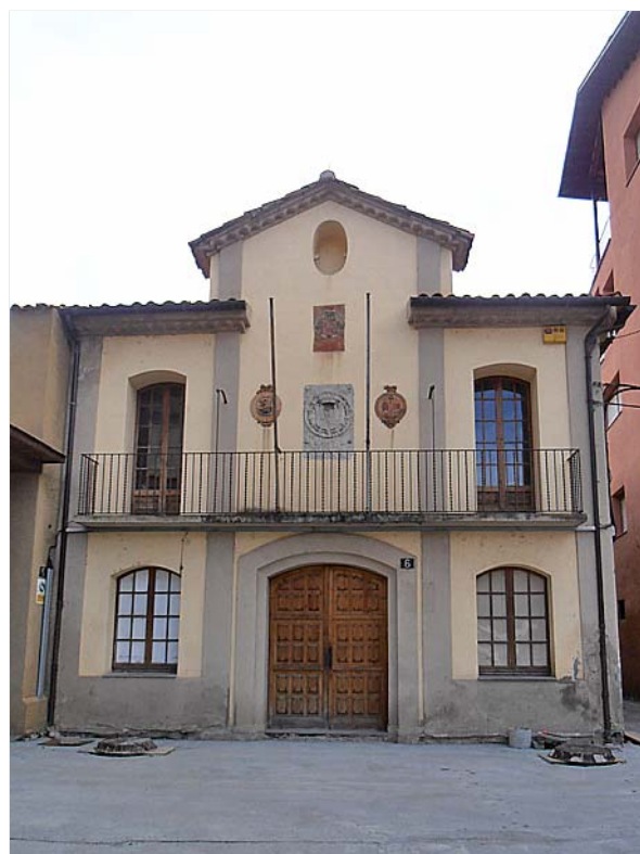
Façana oberta a la Plaça Pati Palau
