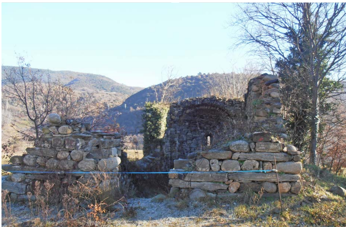
Mur de ponent, amb les traces del que fou l'accés la nau.
