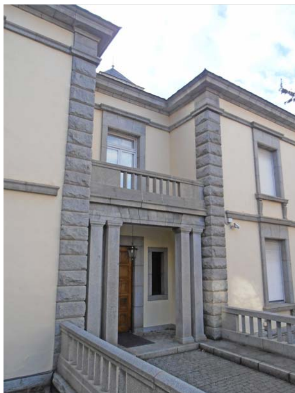
Accés principal a l'habitatge (2015)
