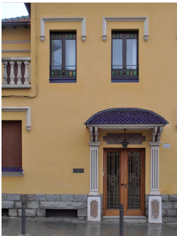
Porta d'entrada emmarcada per dues pilastres (2014)
