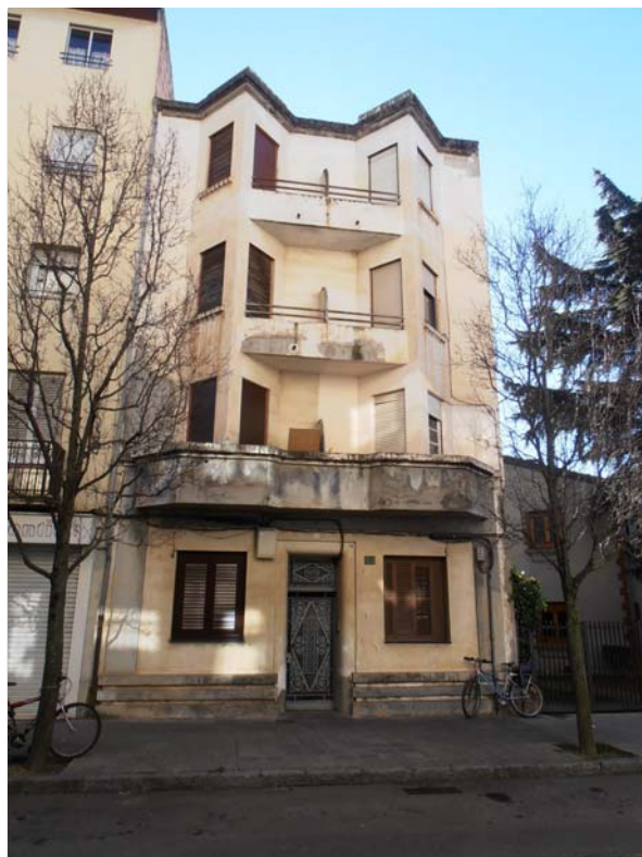
Façana oberta al Carrer sant Ermengol (2015)
