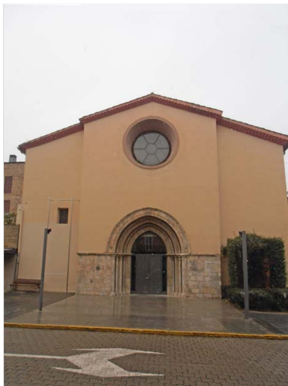
Façana accés a l'església de Sant Domènec.
