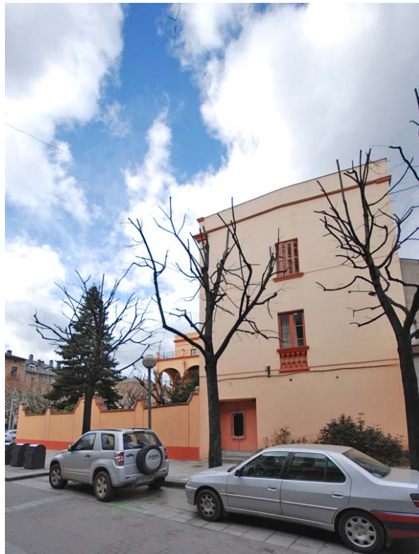
Terrassa situada al primer pis (2015) Façana oberta al pati (2015)
