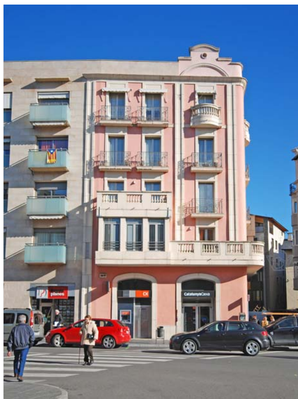
Façana del Carrer Sant Ot
