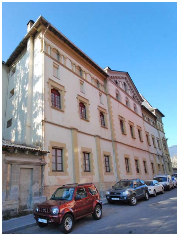
Façana oberta al carrer del Camí de la Palanca (2015)
