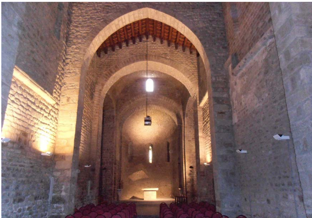
Nau central, coberta de fusta sostingut per arcs de diafragma (2014)
