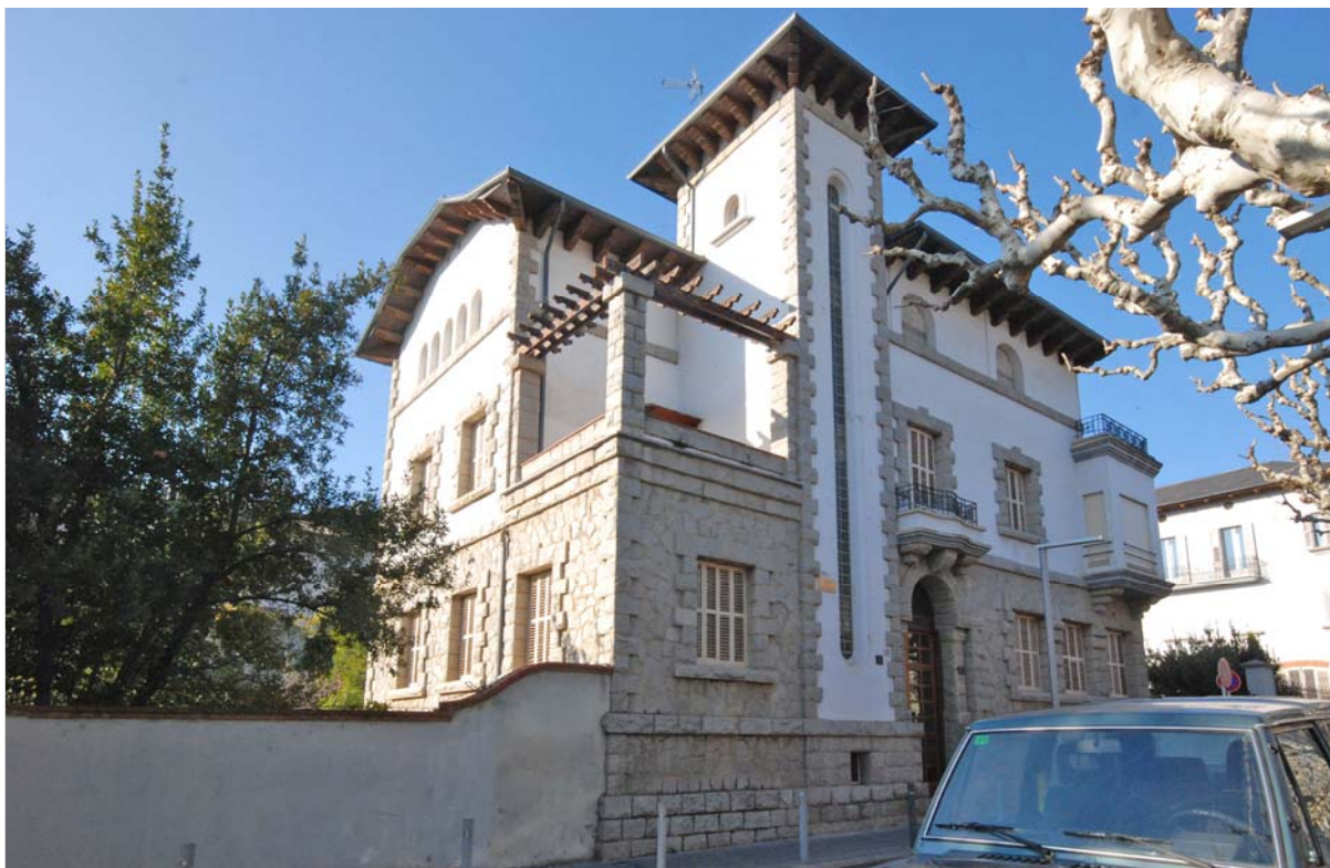
Cantonada sud-est, destaca la combinació d'espais buits i espais plens, i el joc de la línia horitzontal i la vertical (2015)
