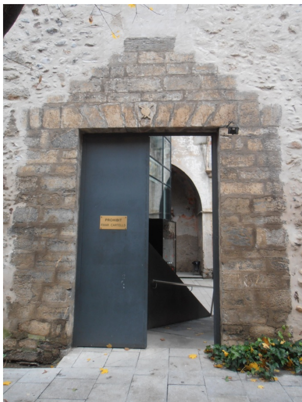
Porta rectangular adovellada situada en la façana nord (2014)
