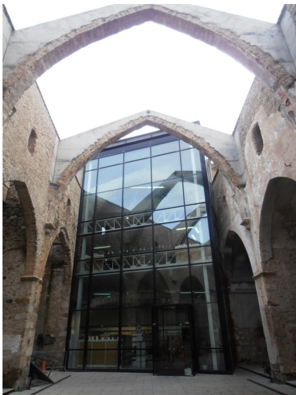
Façana de la biblioteca oberta cap a la nau central.
