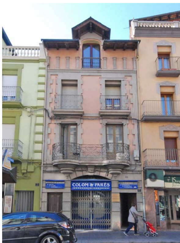
Façana oberta al Carrer Sant Ot. (2015)
