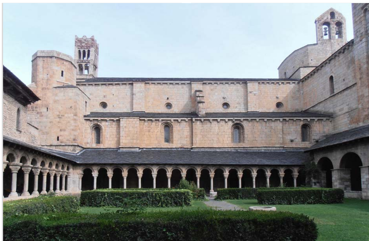
Façana sud vista des del claustre (2014)
