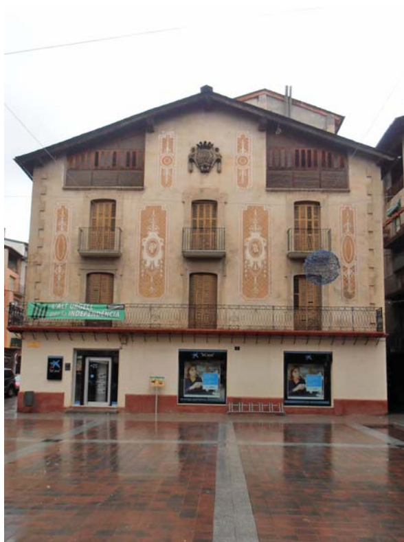
Façana de Cal Mossèn Andreu
