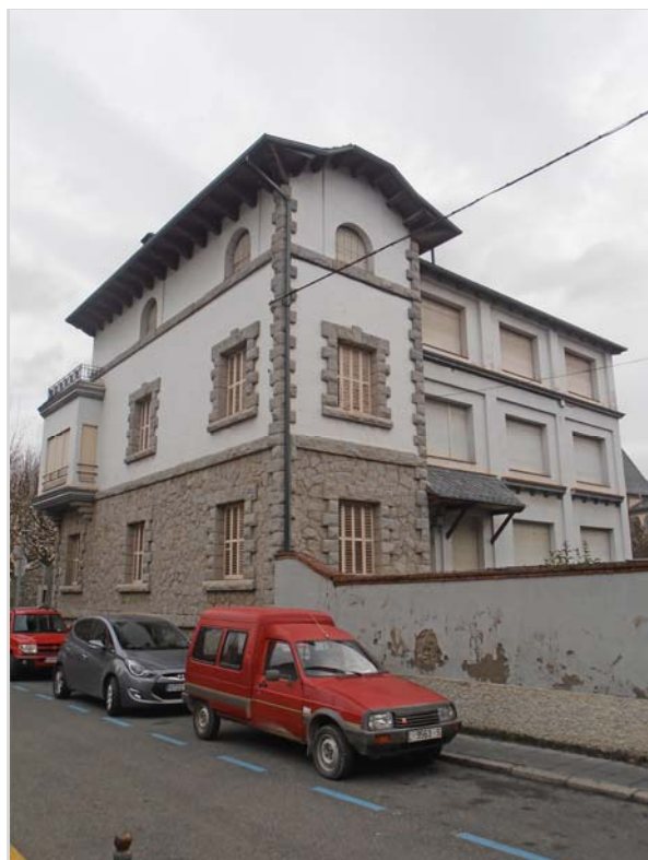
Façana del Ptge. De Pere Riquel. Destaca la combinació del granit amb l'emblanquinat de les parets (2015)
