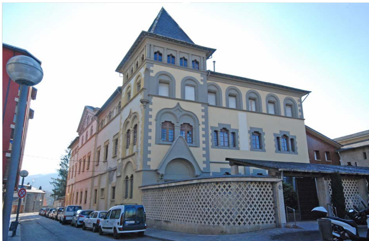
Vista més característica del conjunt, amb la torre en primer pla coronada amb una coberta piramidal allargada coneguda com La Puntxa. (2015)
