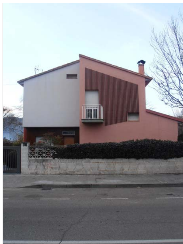
Façana del carrer Sant Ermengol. (2015)
