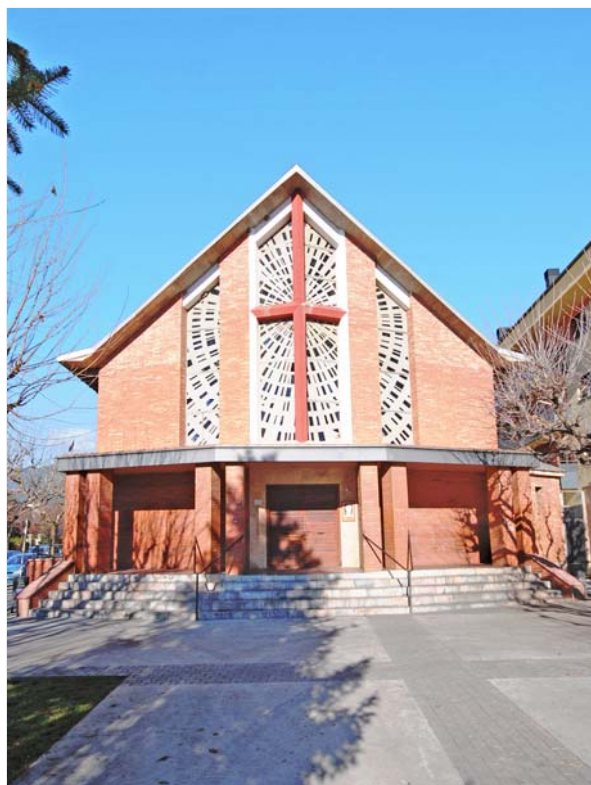
Façana principal oberta al Parc, resolta amb maó vist (2015)
