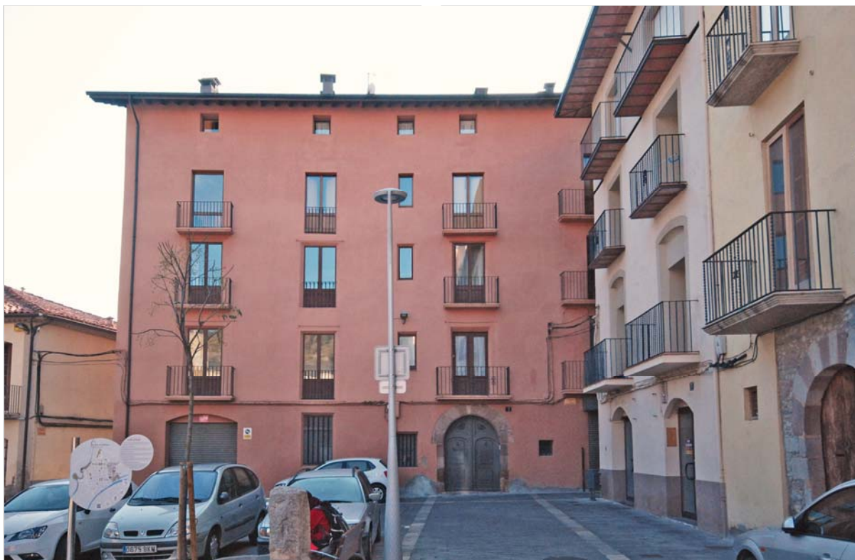
Façana que tanca la cantonada sud oest de la Plaça Pati Palau (2015)
