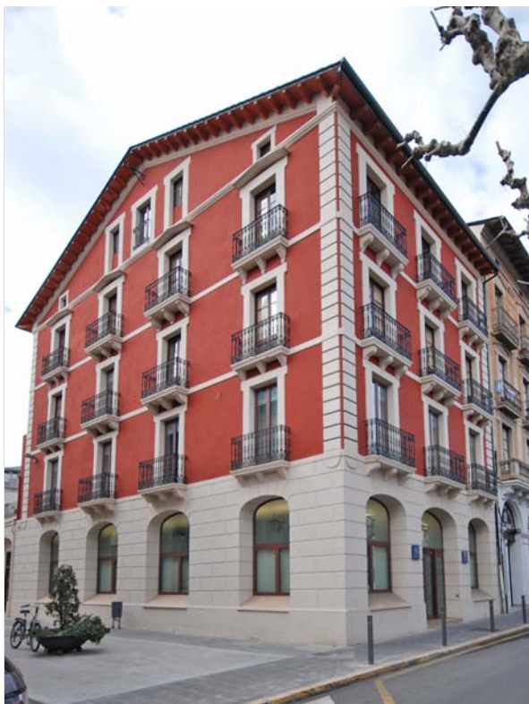
Cantonada sud-est, correspon a les façanes més treballades (2014)
