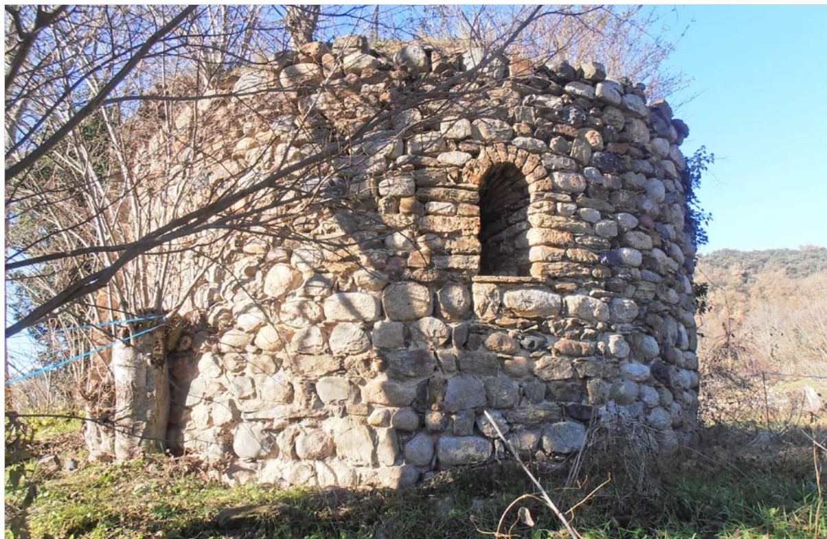
Absis orientat a llevant amb una finestra de doble esqueixada al centre (2015)
