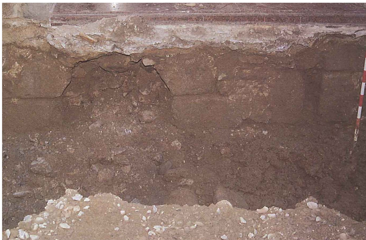
Pany de mur alineat amb la façana del carrer Major.(2014)
