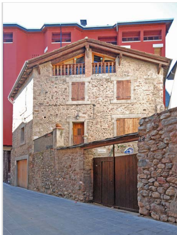
Façana oberta al Carrer de Sant Agustí
