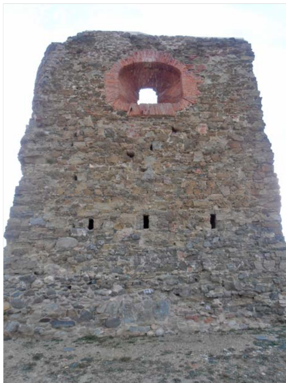
Obertures reforçades amb maó (2015)
