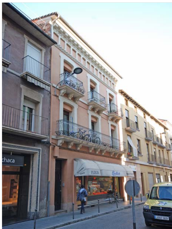
Façana oberta al carrer Sant Ermengol. (2015)
