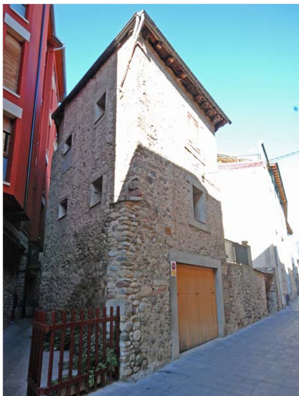
Cantonada que podria respondre al traçat de la muralla (2015)
