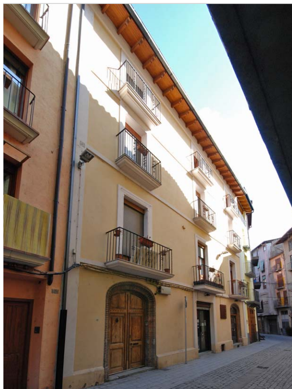
Façana carrer Capdevila (2015)
