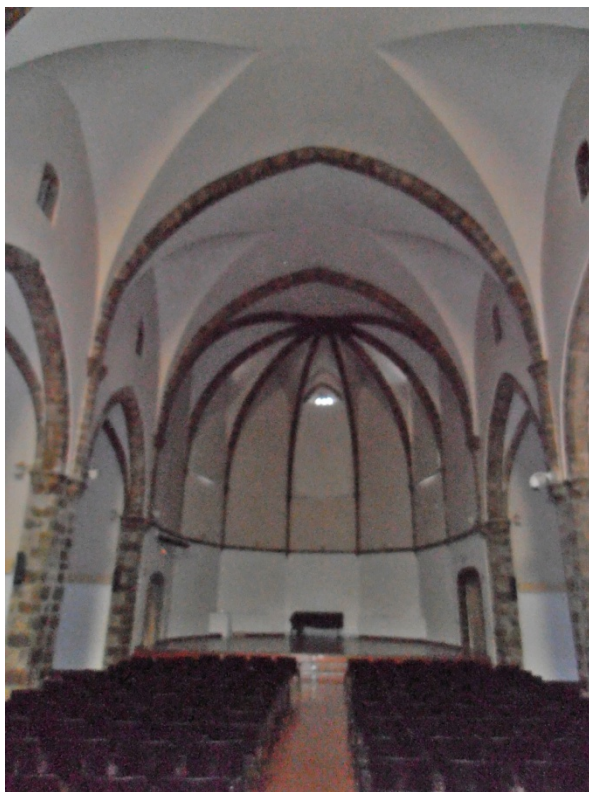
Absis poligonal cobert per colta de creueria amb 8 nervis.
