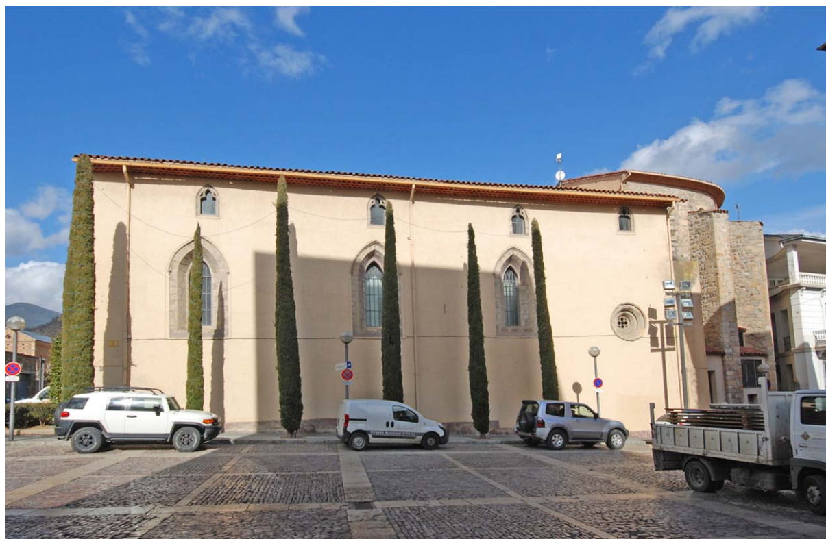
Façana de migdia amb les tres finestres apuntades en un ull de bou circular. (2014)
