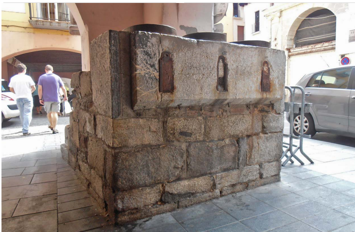
Mesures situades a la cantonada del Carrer Major i el Carrer Capdevila. De les dues estructures, aquesta és la més nova
