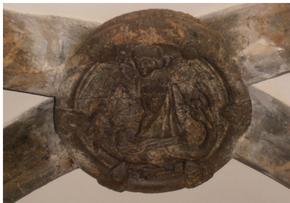
Nau central, amb capelles laterals. Punt d'unió dels 8 nervis de l'absis.
